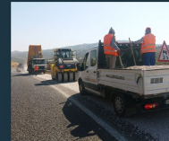
Sathi Kaplama, Asfalt Yapımı
