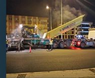
Sıcak Asfalt Yol Yapımı
